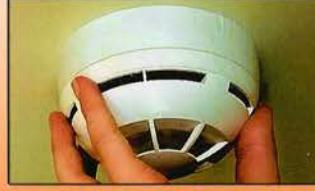
Для раннего обнаружения пожара в квартире и сигнализации о нем установите автономный пожарный извещатель. В этом случае человек будет извещен о пожаре в самом его начале и начнет бороться с ним намного раньше, чем увидит пламя. Извещатель подает световые и громкие звуковые сигналы, поэтому даже ночью можно услышать оповещение. Обнаружив возгорание на ранней стадии, можно если не ликвидировать его, то, по крайней мере, покинуть горящее помещение.
